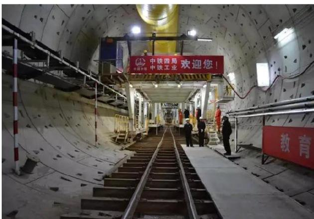
盾构外轮廓高 10.95m, 宽 11.9m, 最大推进速度 60mm/min, 最大推力 13948t, 采用液压驱动, 开挖面设置刀盘 9 个, 单个刀盘最大驱动扭矩 3044kN.m, 装机总功率 3726kw, 9 个刀盘, 每个刀盘都是独立的操控系统, 可随意组合, 能同时、单个和不同方向的旋转。相对圆形盾构机的一个大刀盘旋转、一套控制系统的“粗放”施工, 马蹄形盾构机可以针对不同土层进行最大面积、最大角度的精细开挖。
